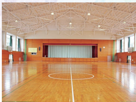
体育館(重層構造の施設)
